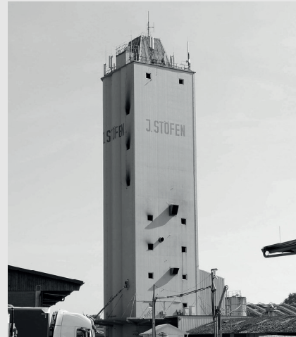
Wesselburen, Schleswig-Holstein, Silo J. Stöfen GmbH, Baujahr 1963
