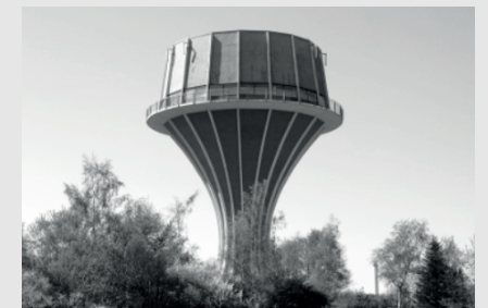
Flensburg, Schleswig-Holstein, Wasserturm Stadtwerke Flensburg, Baujahr 1960-61
